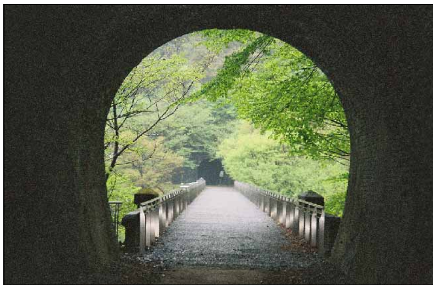
第5トンネルから第3橋梁をのぞむ
