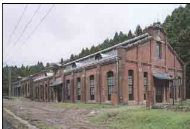
丸山変電所(蓄電池室)
