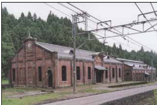
丸山変電所(機械室)
