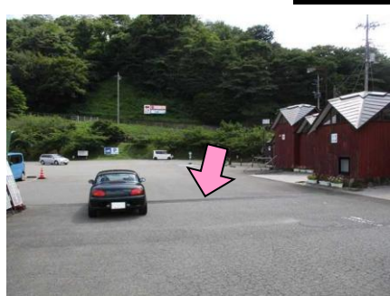
26図『道の駅みょうぎ(みょう ぎ物産センター)』 トイレ前のグレーチング
