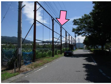
1図 『道の駅白沢』 第三駐車場前 左手のフェンス鉄塔三本目
