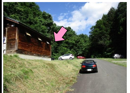
20図 『裏見の滝』駐車場 左手のトイレ 前端
