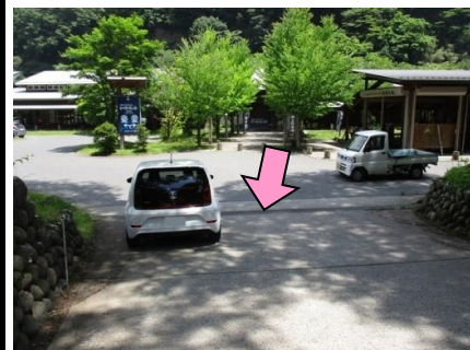
3図『しゃくなげの湯』駐車場 入口 グレーチング
