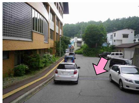
32図『草津町役場駐車場』 グレーチング
