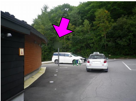
44図 『天狗山第一駐車場』 駐車場 トイレの先にある左手の外灯
