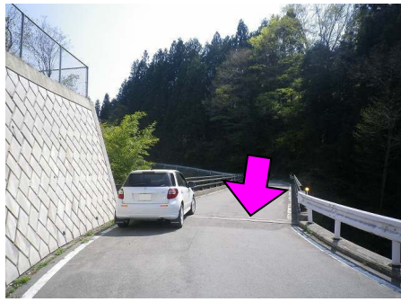
21図先 『青木大橋』入口
