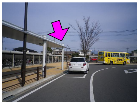
1図 『JR駒形駅』北口 通路屋根の一番先の柱
