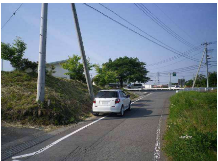
33図先 左手の電柱の添え柱
