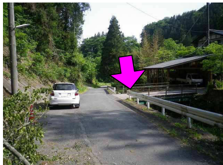
22図先 右手の橋の手前の欄干
