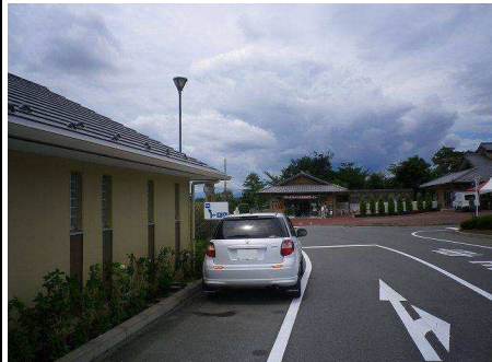
1図 『道の駅 赤城の恵』 トイレの先端角
