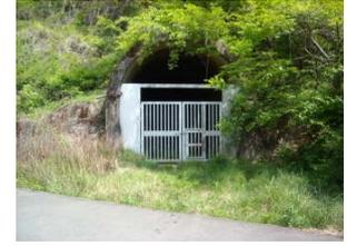
現在のわたらせ渓谷鉄道は、草木ダムの手前にある「神戸(ごうど)駅」を出た後、5.2kmもある草木トンネルを通る。こんなローカル線には似つかない立派なトンネルであり、その中の軌道は新幹線などと同じスラブ軌道で、私の記憶が間違っていなければレールのつなぎ目がないロングレールが敷かれている。わたらせ渓谷鉄道に乗った時、それまでの低規格の軌道を走るローカル線の気動車が、トンネルに入った途端、高速鉄道になった様な雰囲気変わった事を覚えている。神戸駅と沢入駅の間は、草木ダム建設のため付け替えられた新線区間である。草木ダムの工事が始まってから、新線が完成するまでのわずか約1年半の間使用されたトンネルが3CP右手の廃トンネルである。
