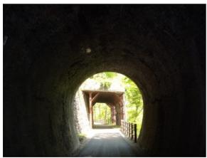
トンネルを抜ける辺りで、先にロックシェッドが見えてくる。この柱にはレールが使われている。
